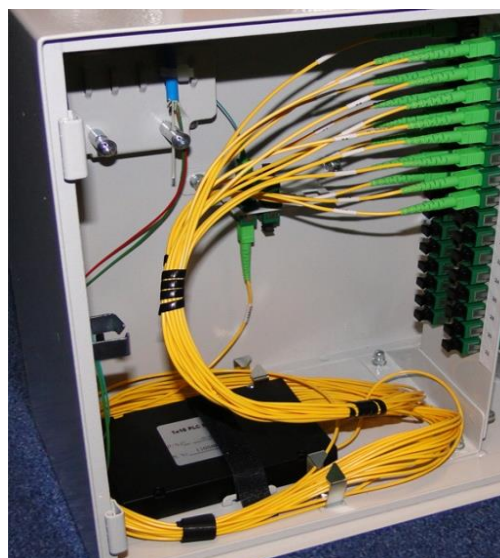
Fot.8 Zamontowany sprzęgacz optyczny.
