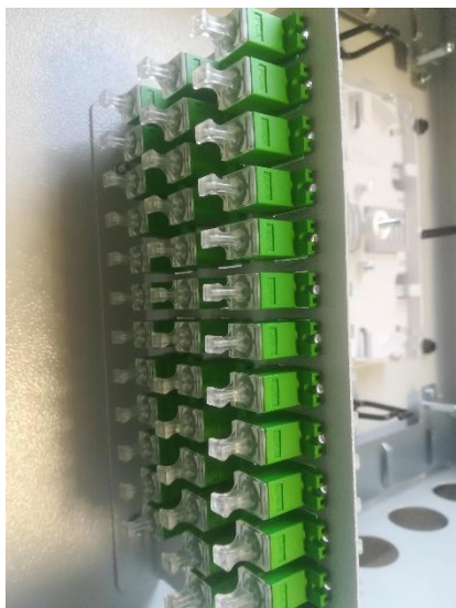
Fot.1 Pole liniowe z adapterami typu SC/APC.
