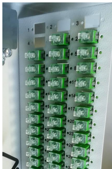
Fot.2 Pole abonenckie z adapterami typu SC/APC.
