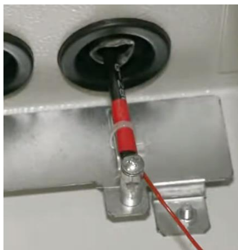
Fot.4 Zamocowany kabel liniowy
