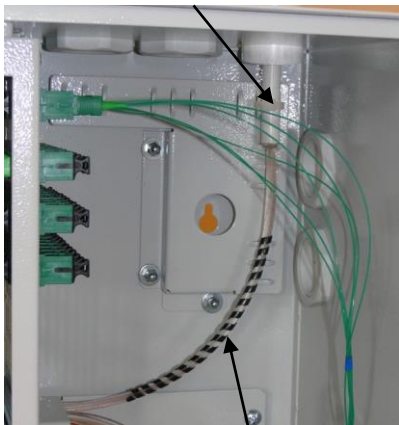
Zabezpieczenie włókien kabla stacyjnego węże spiralnym
