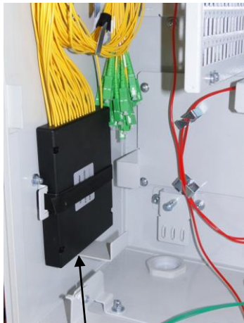
Montaż sprzęgacza w uchwycie
